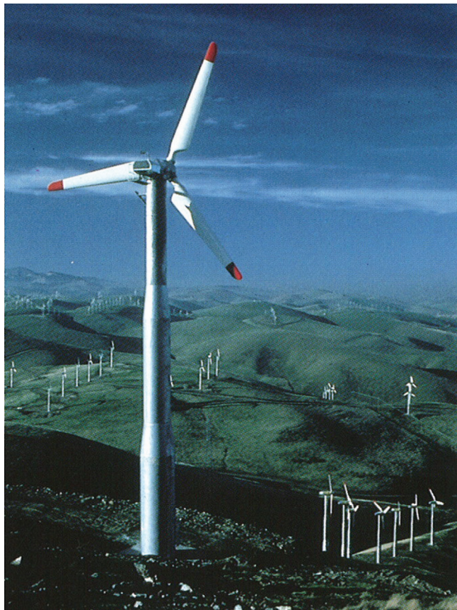
Figur 19.6 Vindenergiverk, Altamont Pass, USA
