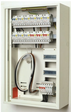
Figur 9.4 Fordelingsskap under bygging
